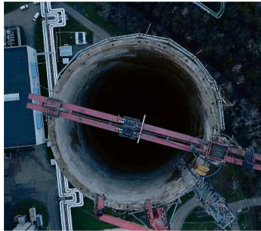
Und hier der Blick ins Auge des Schornsteins. Derzeit ist die Esse noch das größte Bauwerk Thüringens.
