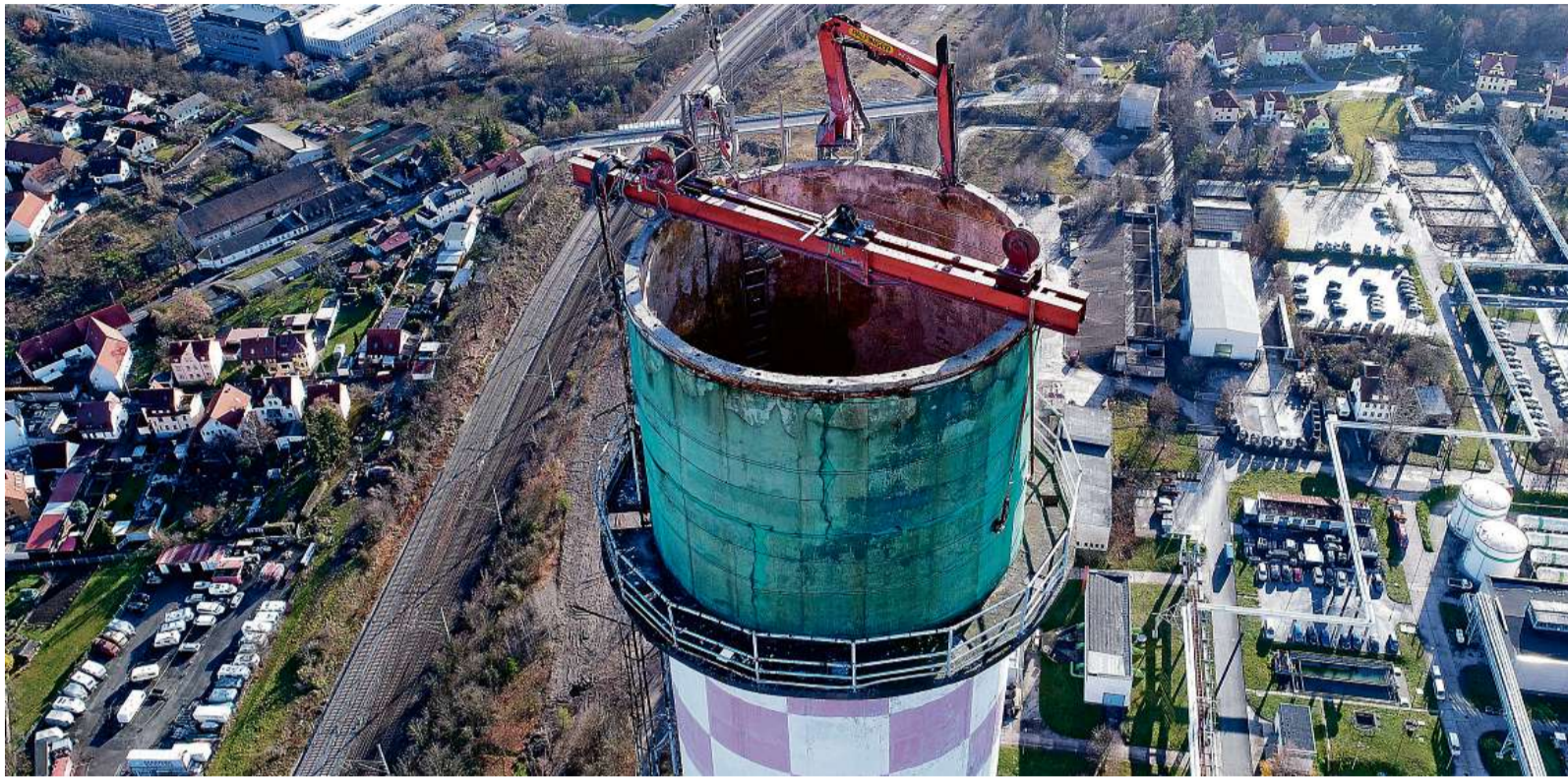
Erster Abschnitt des Umbauprojekts im Heizkraftwerk ist der Abriss einer der beiden Schornsteine. Der 225 Meter hohe, fast 40 Jahre alte Schlot soll Stück für Stück abgetragen werden. FOTOS (2): TEAG
