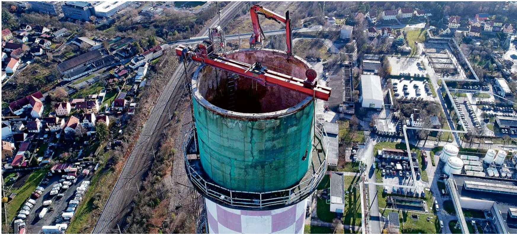
Erster Abschnitt des Umbauprojekts im Heizkraftwerk ist der Abriss einer der beiden Schornsteine. Der 225 Meter hohe, fast 40 Jahre alte Schlot soll Stück für Stück abgetragen werden. FOTOS (2): TEAG
